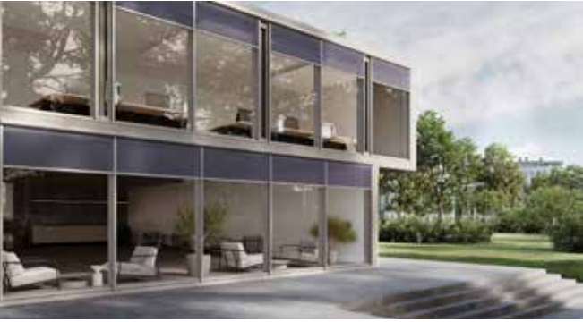
Montáž na fasádu
