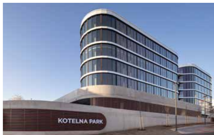
Kotelna Park II Prag, Tschechien BREEAM „Very good“ zertifiziert
